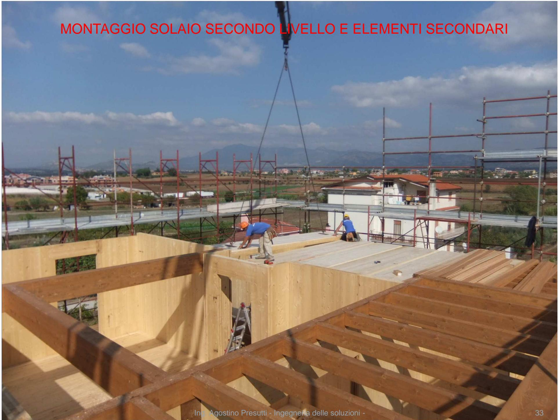
MONTAGGIO SOLAIO SECONDO LIVELLO E ELEMENTI SECONDARI
