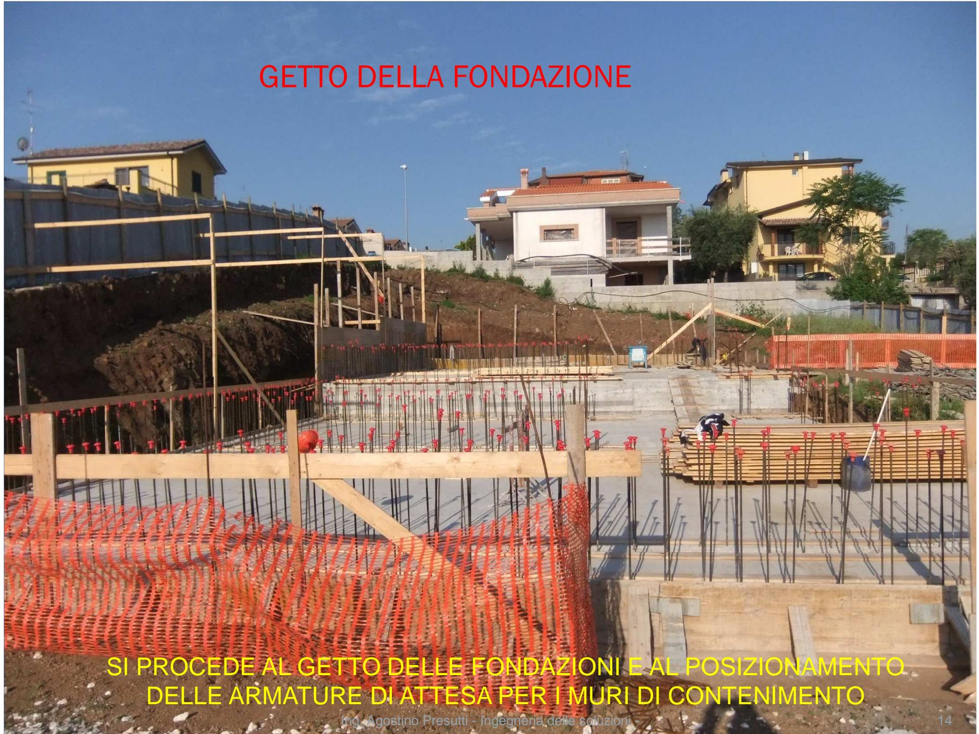
SI PROCEDE AL GETTO DELLE FONDAZIONI E AL POSIZIONAMENTO DELLE ARMATURE DI ATTESA PER I MURI DI CONTENIMENTO
